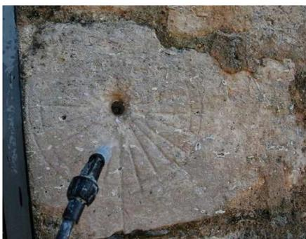
Fig 7 : Rinçage au pulvérisateur
